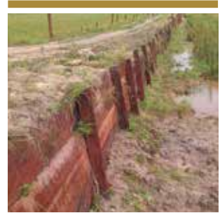
Pembuatan Turap Retaining Wall Construction
