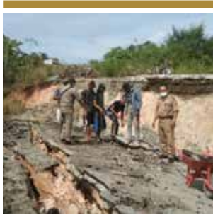
Perbaikan Jalan Longsor Collapsed Road Repair
