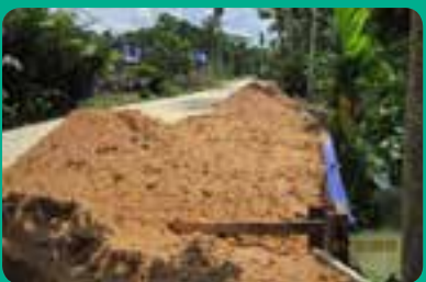
Perbaikan Jembatan/ Turap Jalan Longsor Repair of Bridge Sheet Pile
